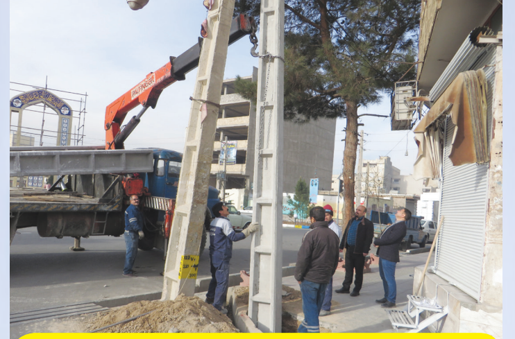
جابجایی تیر برق های مزاحم
