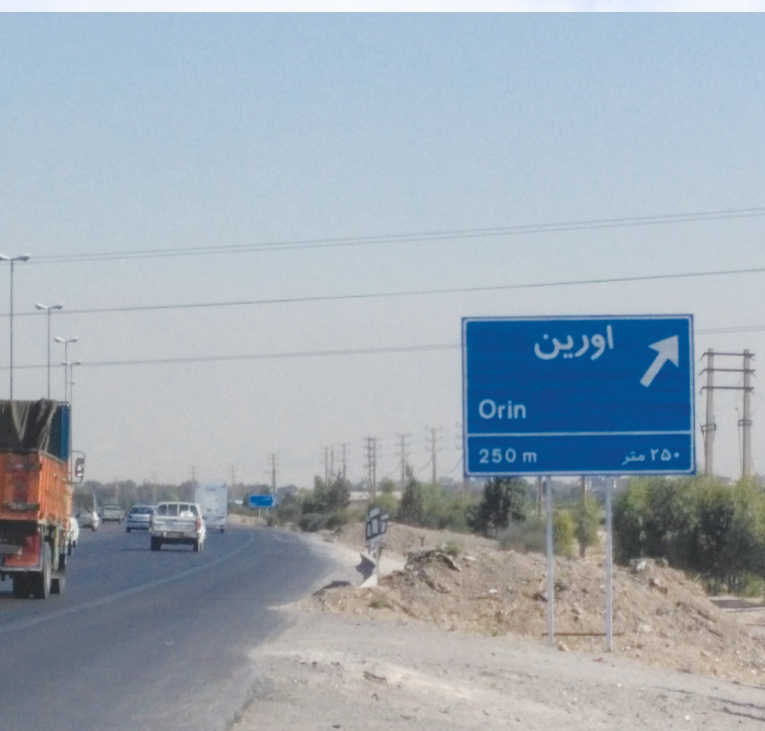
نصب تابلو راهنمایی اتوبان تهران ساوه
