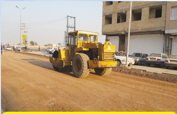
اجرای بلوار وحدت
