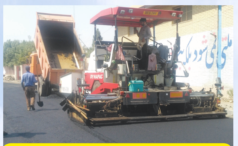
آسفالت ریزی خیابان شهید اکبر کافی
